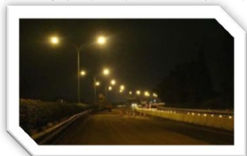
400W高压钠灯道路
